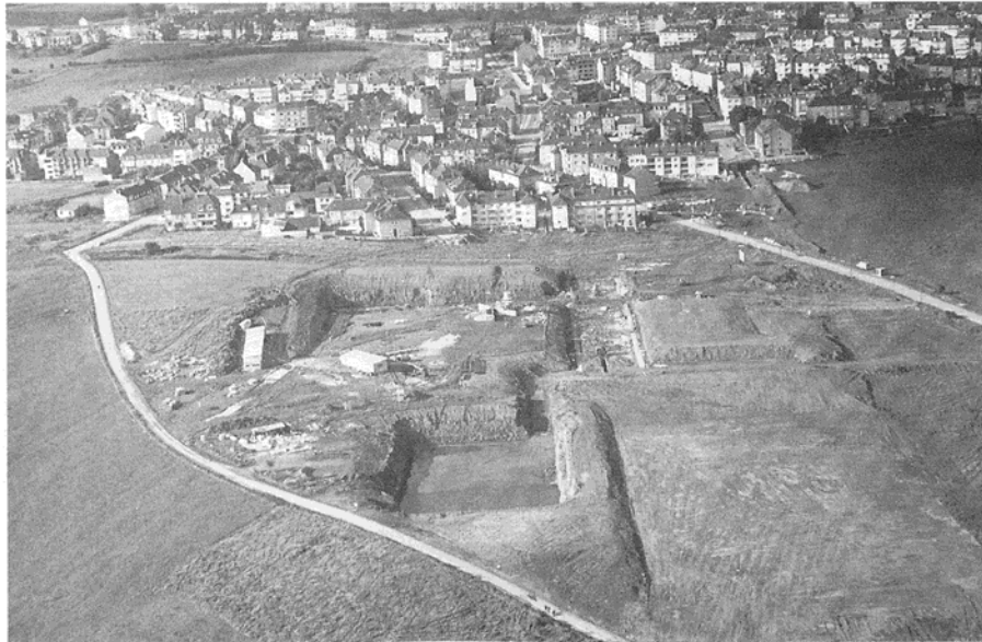
Vue aérienne des fondements du 'nouvel' Athénée.
