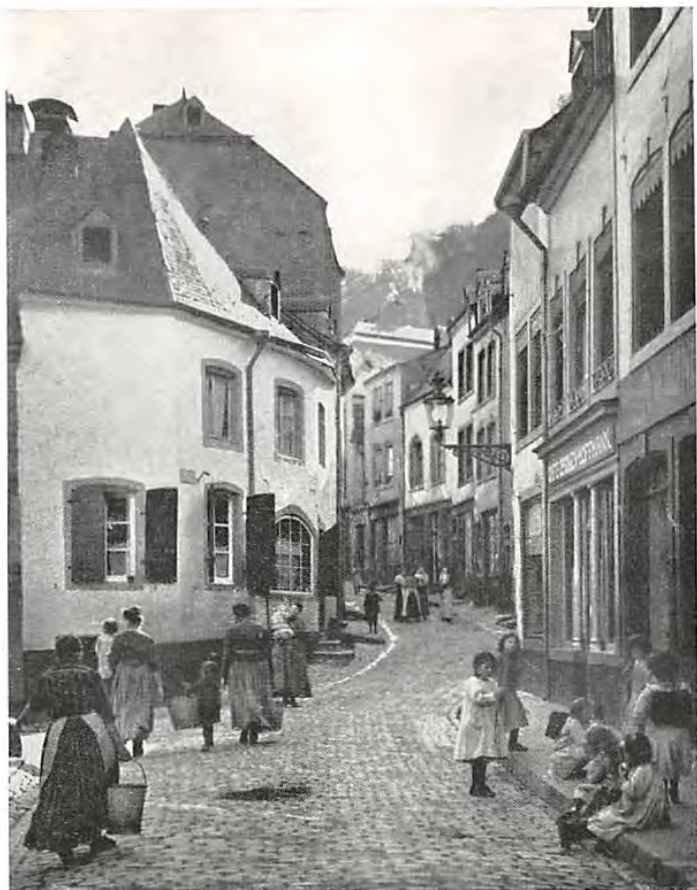
PARTIE SUPÉRIEURE DE LA RUE LAURENT MÉNAGER avec sa population grouillante. (Photo Batty Fischer)
