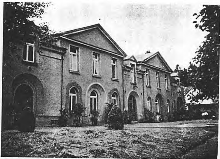
Maison de retraite de Bofferdange
