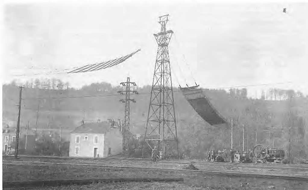
Eine Seilbahn brachte die Schlacke von der Hütte über Alzette und Beggenerstraße zum Tipp (1942)
