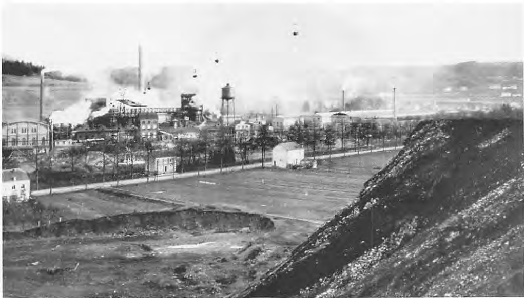
Ateliers de l'Arbed à Dommeldange (1920)
