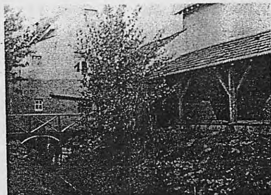
Unterhalb der Mühle. Links Steg über dem Wasserkanal, der aus der Mühle austritt.
