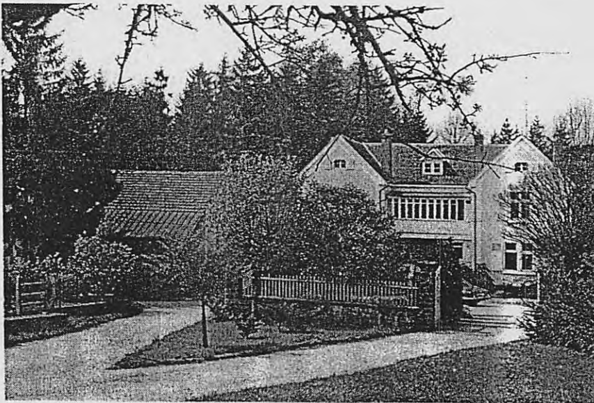
Die als „Villa“ umgebaute Mühle im Jahre 1974.
