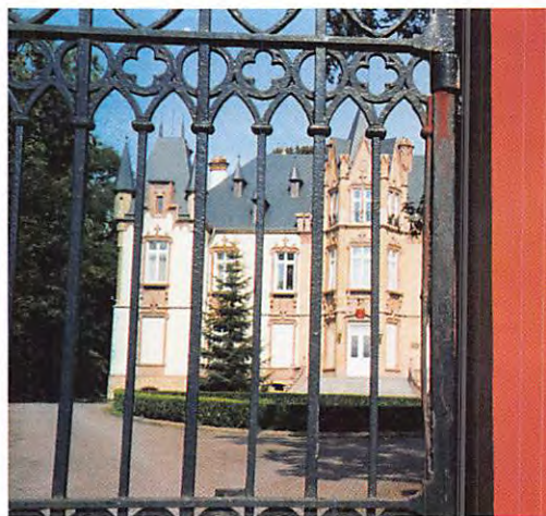
(à droite) L'ambassade de Chine occupe l'ancienne résidence des COLLART à Dommeldange.
