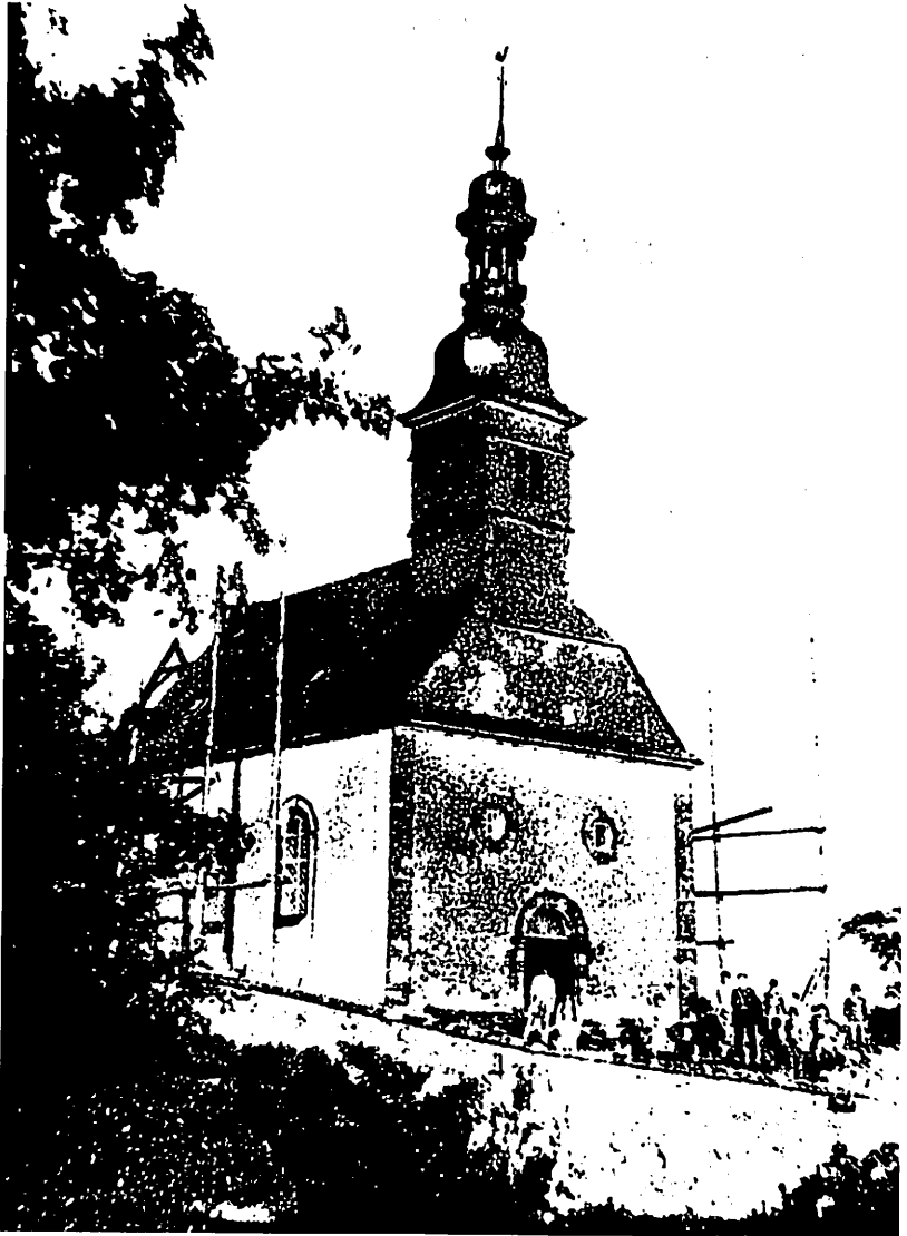
L'église Saint-Pierre de Bous en Sarre. Photo prise lors des travaux de démolition en 1890.
