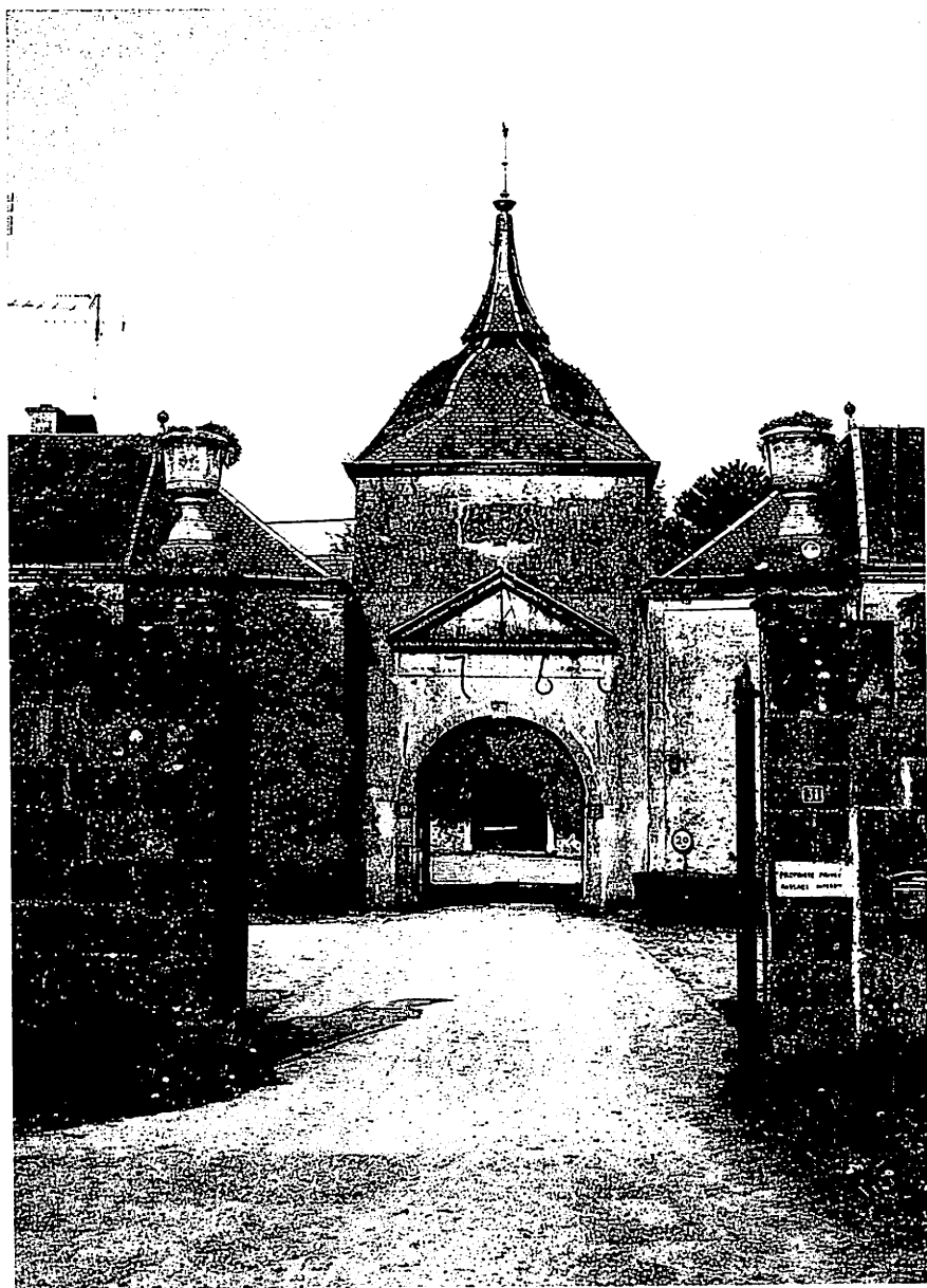
La majestueuse entrée de 1763 dans la cour du château de Guirsch, construit lui en 1749 (Photo: Jean-Claude MULLER en été 1999).
