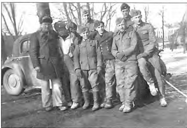
Pause pendant les travaux de déblayement
