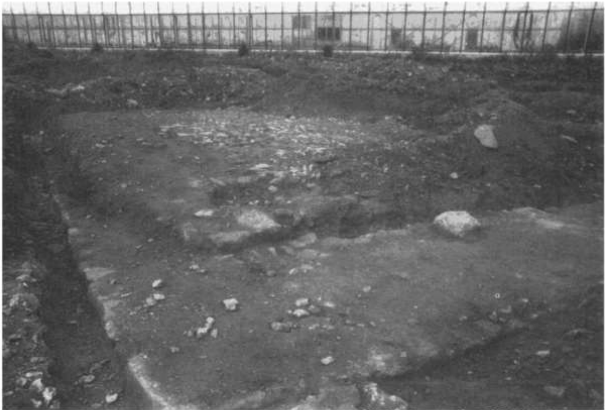
Die Fundamente des Wohnturmes (Foto R. Krantz)
