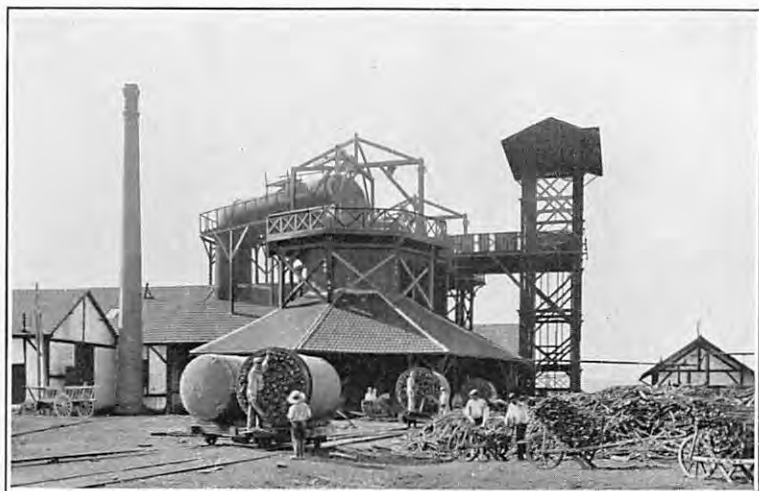
Chargement des fours
