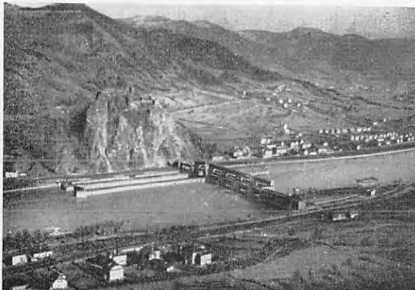
Le barrage de l'Elbe
