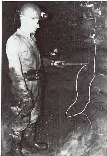
Thillenberg, Differdingen. 1: Sofort nach der Sprengung wurde die Umgebung nach losem Gestein abgeklopft. Alles war nun mit ätzendem Rauch durchsetzt (daher das unscharfe Bild). 2: Dieser Stollen sah aus wie ein unterirdischer Bergsee; er ist etwa 20 Meter unter dem Flußbett des luxemburgisch-französischen Flusses Crosnière gelegen. 3: Der Sprengmeister führte vorsichtig die Patronen in die Bohrlöcher. Dann wurden die einzelnen Patronen durch Zündschnüre miteinander verbunden. 4: Steiger Jean Eberhard kontrolliert die Holzstützen, die an besonders gefährlichen Stellen errichtet wurden.
