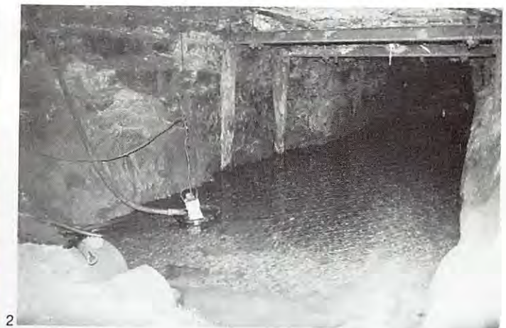
Thillenberg, Differdingen. 1: Sofort nach der Sprengung wurde die Umgebung nach losem Gestein abgeklopft. Alles war nun mit ätzendem Rauch durchsetzt (daher das unscharfe Bild). 2: Dieser Stollen sah aus wie ein unterirdischer Bergsee; er ist etwa 20 Meter unter dem Flußbett des luxemburgisch-französischen Flusses Crosnière gelegen. 3: Der Sprengmeister führte vorsichtig die Patronen in die Bohrlöcher. Dann wurden die einzelnen Patronen durch Zündschnüre miteinander verbunden. 4: Steiger Jean Eberhard kontrolliert die Holzstützen, die an besonders gefährlichen Stellen errichtet wurden.
