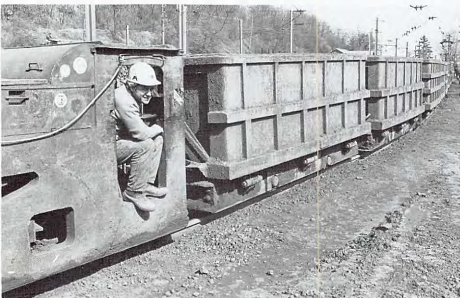
Thillenberg, Differdingen. 1: Diese mächtigen Arbeitsmaschinen, deren Schaufeln 10 Tonnen Gestein fassen, arbeiteten im Innern des Berges. Deshalb mußten für diese Maschinen die Zufahrtsstollen erhöht und verbreitert werden. 2: Mit der beweglichen Kanzel dieser polyvalenten Maschine gelangte der Bergmann bis unter die Stollendecke. 3: Wagenkolonnen rollten bis in die Tiefe des Berges zum Abtransport der Erzmassen. 4: Kilometerlange Gänge führten in den Berg bis zu den Arbeitsstellen. Die viereckigen Platten an den Decken, mit Bolzen im Gestein verankert, sollten loses Gestein festhalten. 5: Unter ohrenbetäubendem Getöse brachte die Lademaschine das Gestein zur Wagenkolonne.
