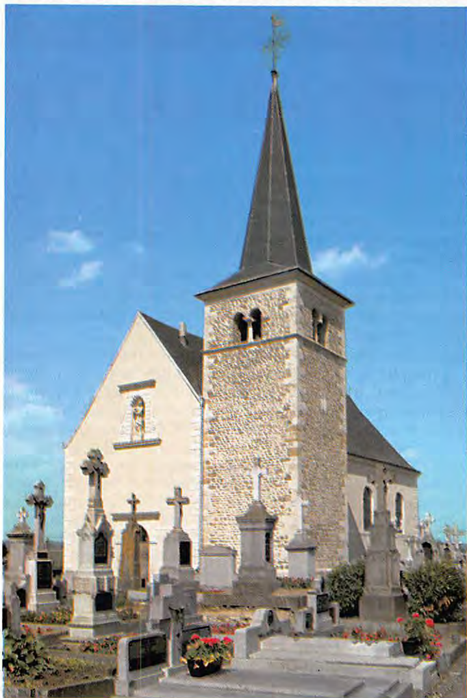
Pfarrkirche St-Martin in Frisingen. Bild 1: Gesamtansicht der Kirche (erbaut 1731-34; konsekriert am 8. Juli 1735). 2: Romanische Schalllöcher im Turm, Mauerwerk mit Eckverstärkungen in Haustein.
