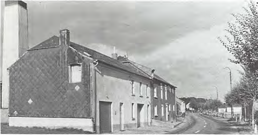
Geräteschuppen der Feuerwehr (in der Rippweilerstraße) und Versammlungslokal, ein Gemeinschaftswerk der Nördinger Bevölkerung (Foto: Jean Weyrich)
