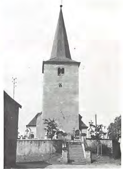
Die Ostseite des machtvoll emporstrebenden Turmes von Lannen, der ursprünglich ein römischer Wach- und Verteidigungsturm war. Oben befindet sich die romanische Zwillingsoffnung, darunter das romanische Fensterchen (Foto: Archiv Luxbg. Wort).
