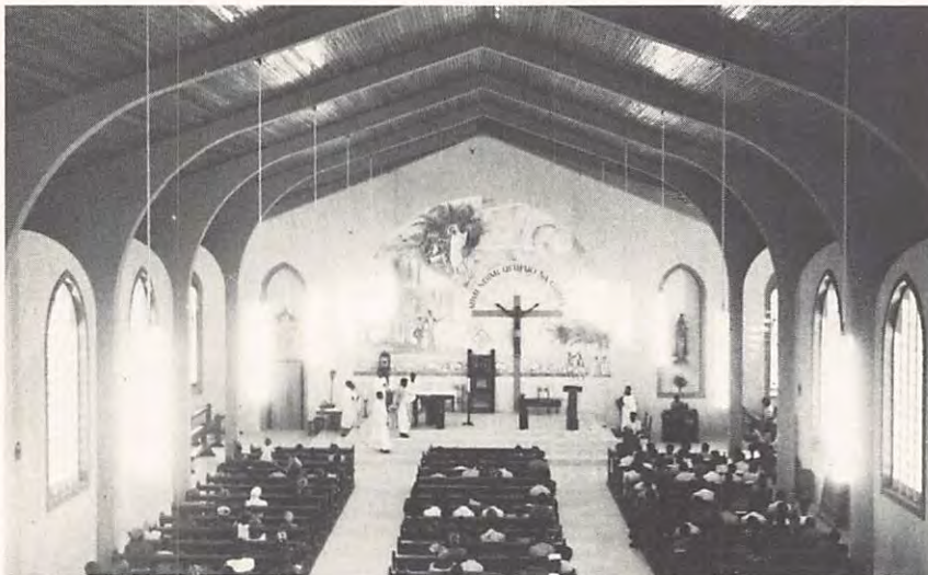
Blick in den restaurierten Innenraum der Kathedrale.
