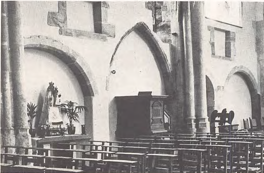
St. Michaelskirche: Die Nordmauer mit deutlich erkennbaren, bei der Restaurierung (1964) freigelegten bogenüberwölbten Wandnischen
