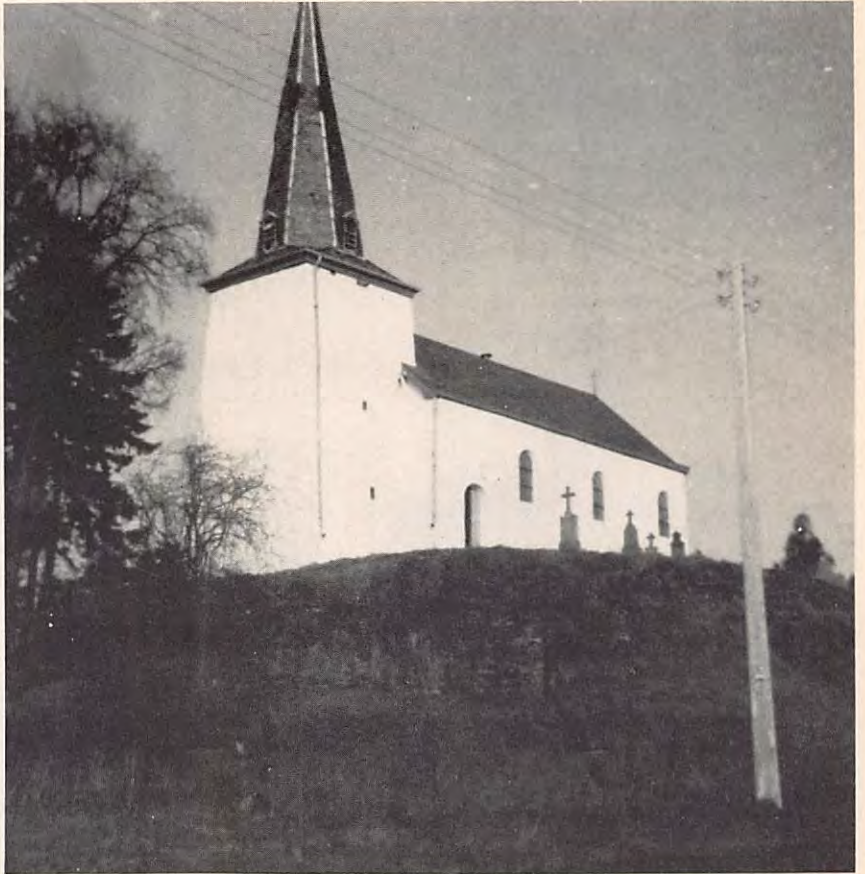
Die Kirche von Wathermal. Ihre Lage auf einem Felsenvorsprung, der Turm (ohne die Spitze), die 1,50 m dicken Mauern, die kleinen und engen Fensteröffnungen, die sich nach innen in Schießscharten erweitern, das eigenartige Gewölbe: alles deutet darauf hin, daß es sich um eine im 11. oder 12. Jahrhundert errichtete Verteidigungs- oder Schutzfeste handelt. Die alten klangvollen Glocken wurden 1369 gegossen
