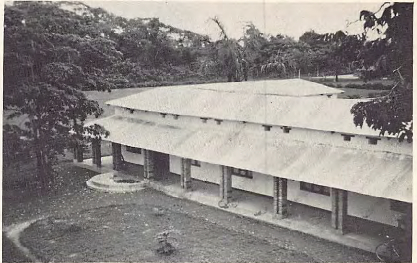
Wohnhaus der Mission Yaleko, das von P. Freilinger selbst erbaut wurde
