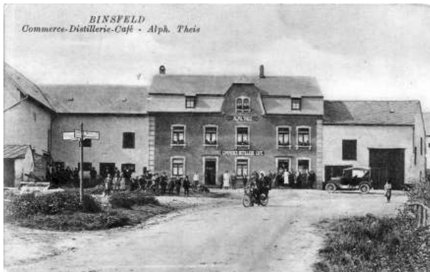
Das Theis-Haus in Binsfeld
